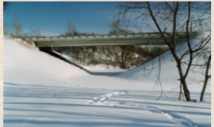
Pont aujourd'hui Photo : 1993-02-28 Travaux terminés à la fin de 1992
