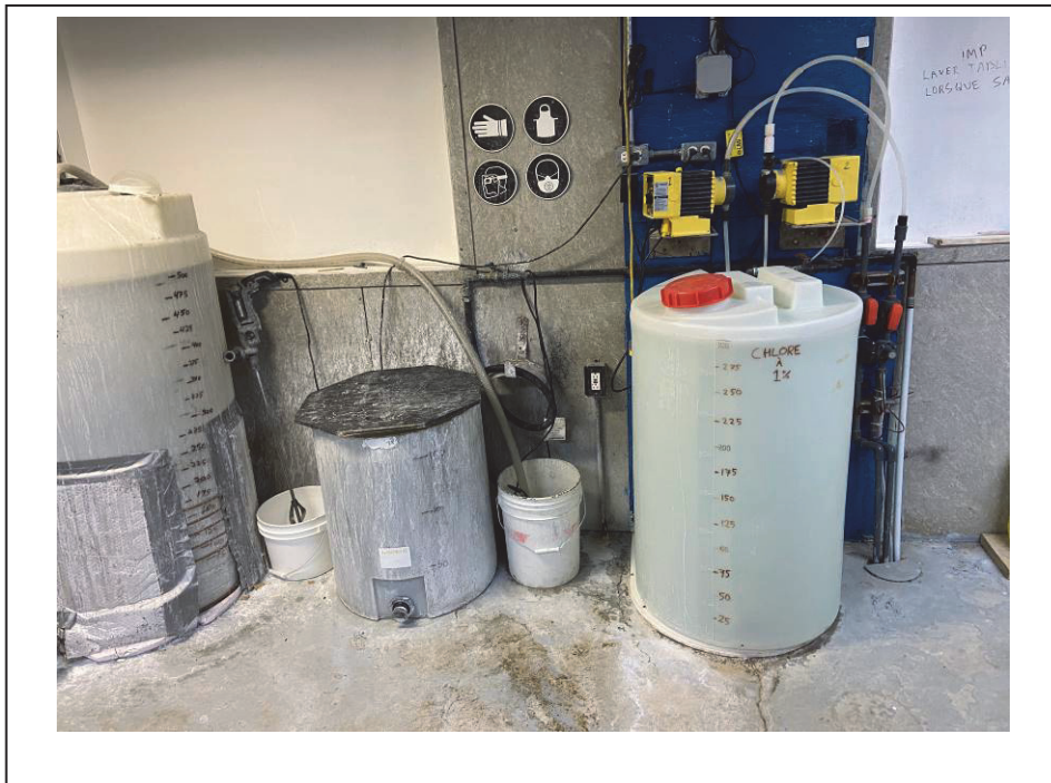
Photo 15 : Vue des réservoirs de produits chimiques (hypochlorite de sodium à gauche et métrasilicate de sodium à droite) et de leur pompe doseuse– 2020-12-18
