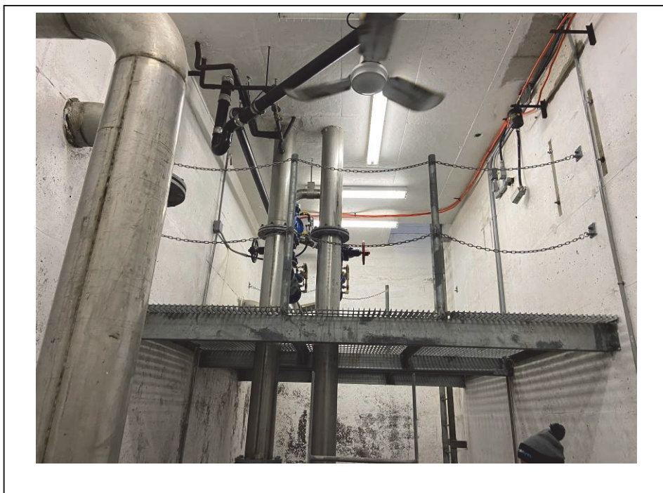
Photo 18 : Canalisation provenant de la station de traitement – 2020-12-18
