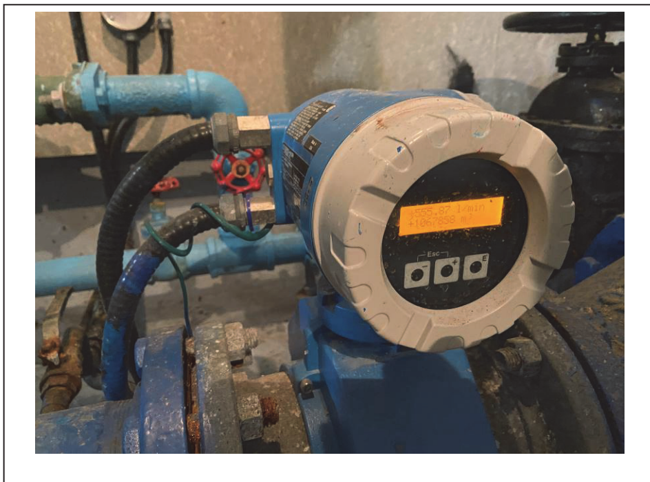
Photo 14 : Débitmètre à l'entrée de la station de traitement – 2020-12-18
