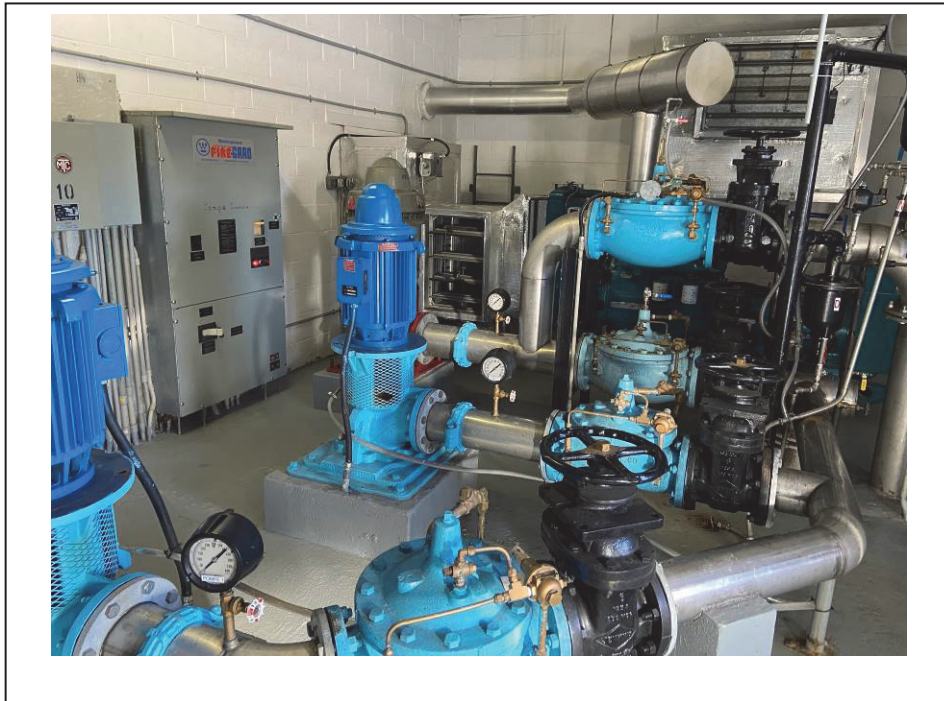
Photo 19 : Canalisation et pompe de la station de distribution – 2020-12-18
