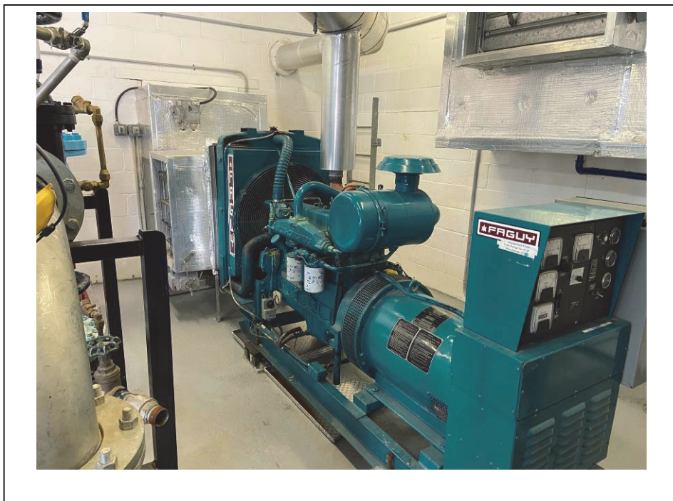
Photo 22 : Vue de la génératrice à l'intérieur de la station de traitement – 2020-12-18
