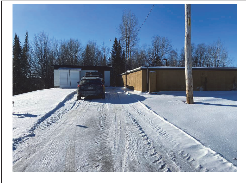
Photo 11 : Accès à la station de traitement et le premier réservoir – 2020-12-18
