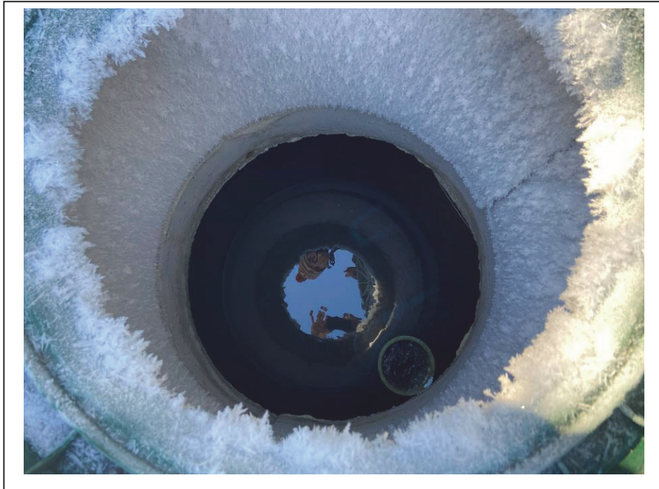
Photo 3 : Vue intérieure du réservoir de la source n° 1– 2020-12-18
