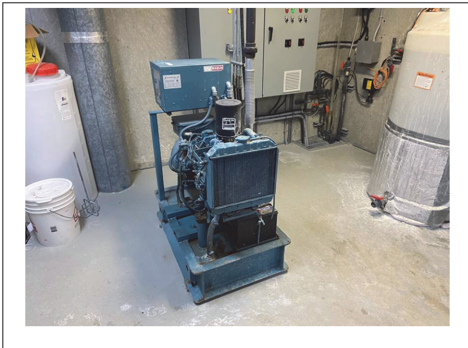
Photo 16 : Vue de la génératrice à l'intérieur de la station de traitement – 2020-12-18
