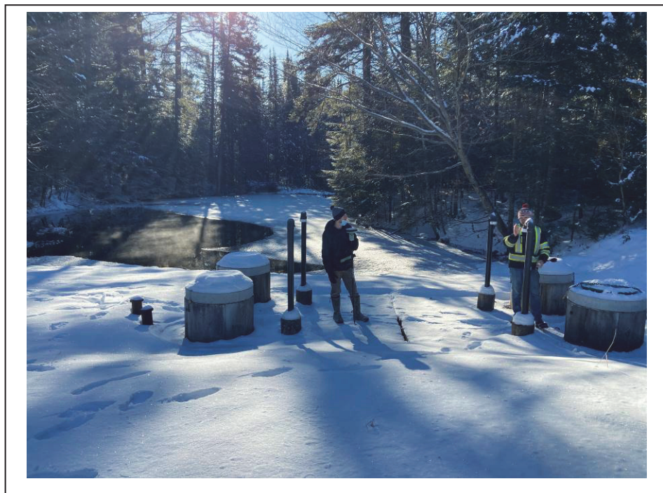
Photo 2 : Vue du réservoir en béton de la source n° 1 – 2020-12-18
