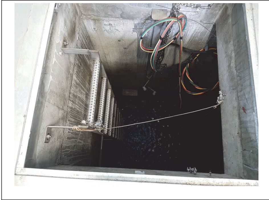
Photo 23 : Accès aux réservoirs d'eau potable – 2020-12-18
