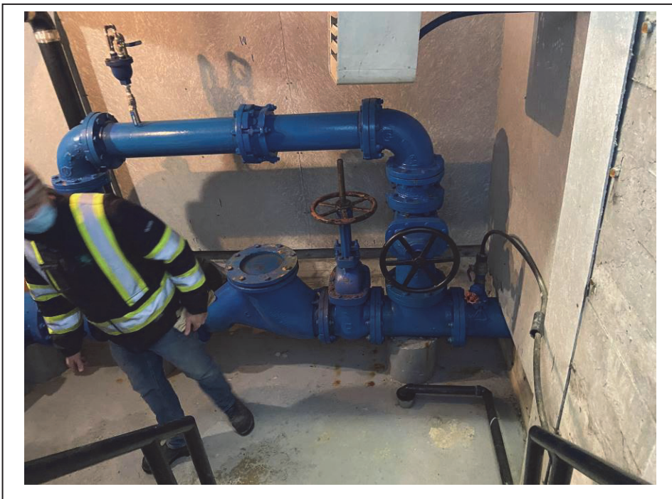
Photo 10 : Canalisations de la station de surpression– 2020-12-18
