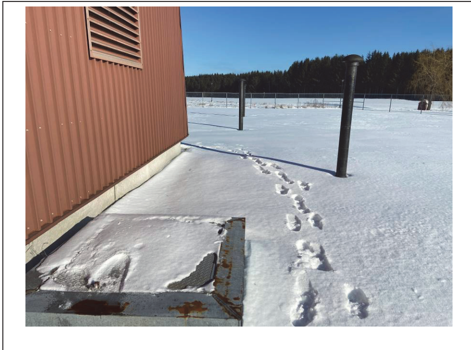
Photo 21 : Vue de derriere de la station de distribution avec son réservoir souterrain – 2020-12-18
