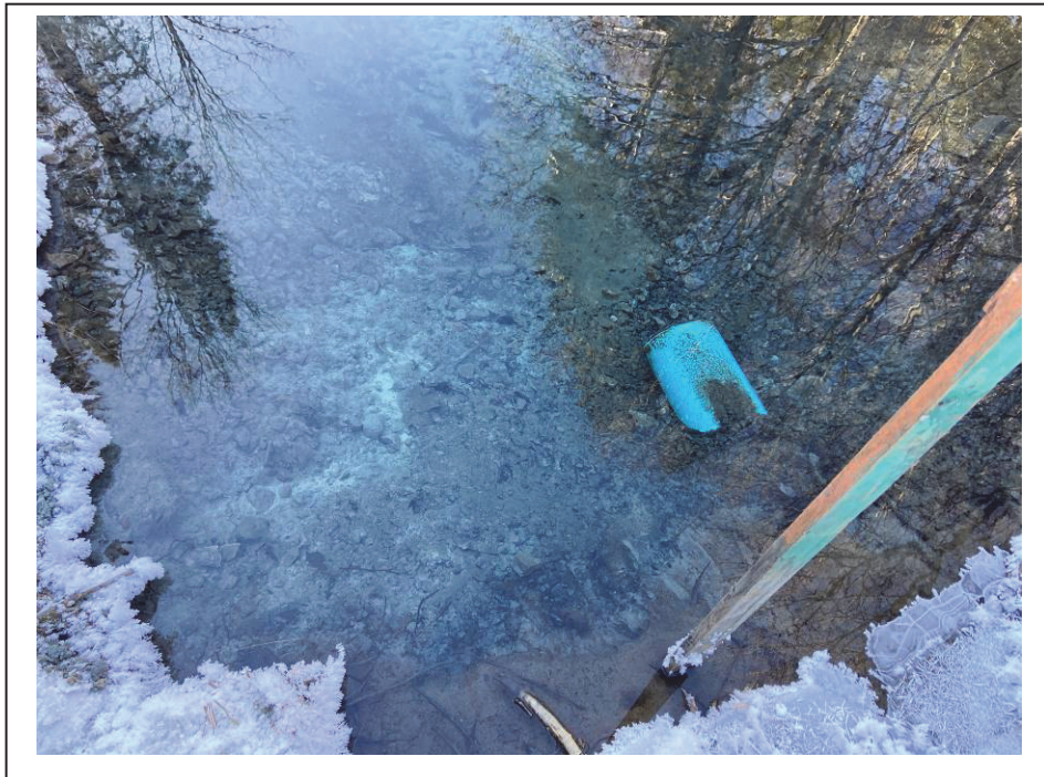
Photo 7 : Canalisations de la source n° 2 – 2020-12-18
