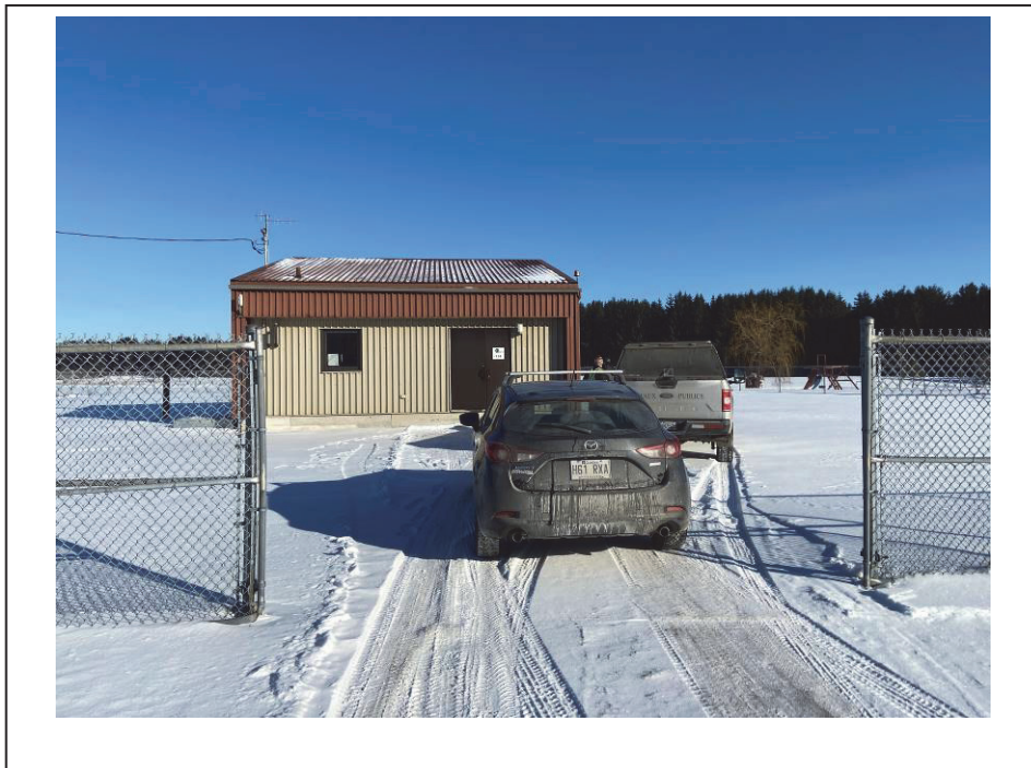
Photo 17 : Accès à la station de distribution et son réservoir – 2020-12-18
