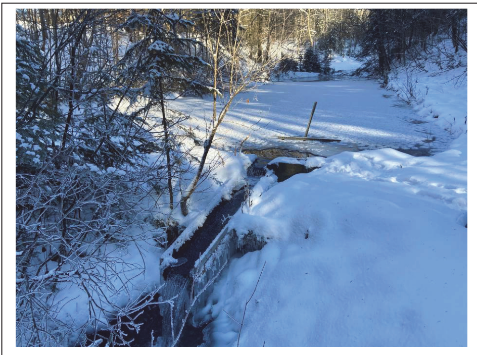
Photo 8 : Bassin en aval de la source n° 2, qui sert comme réserve d'incendie – 2020-12-18
