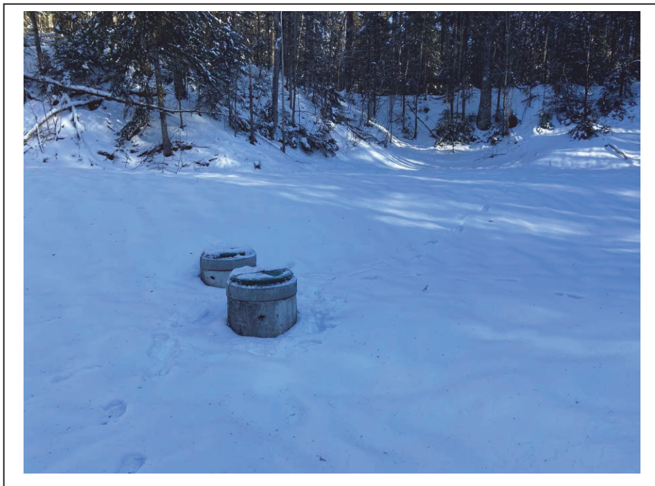
Photo 6 : Vue du réservoir en béton de la source n° 2 – 2020-12-18
