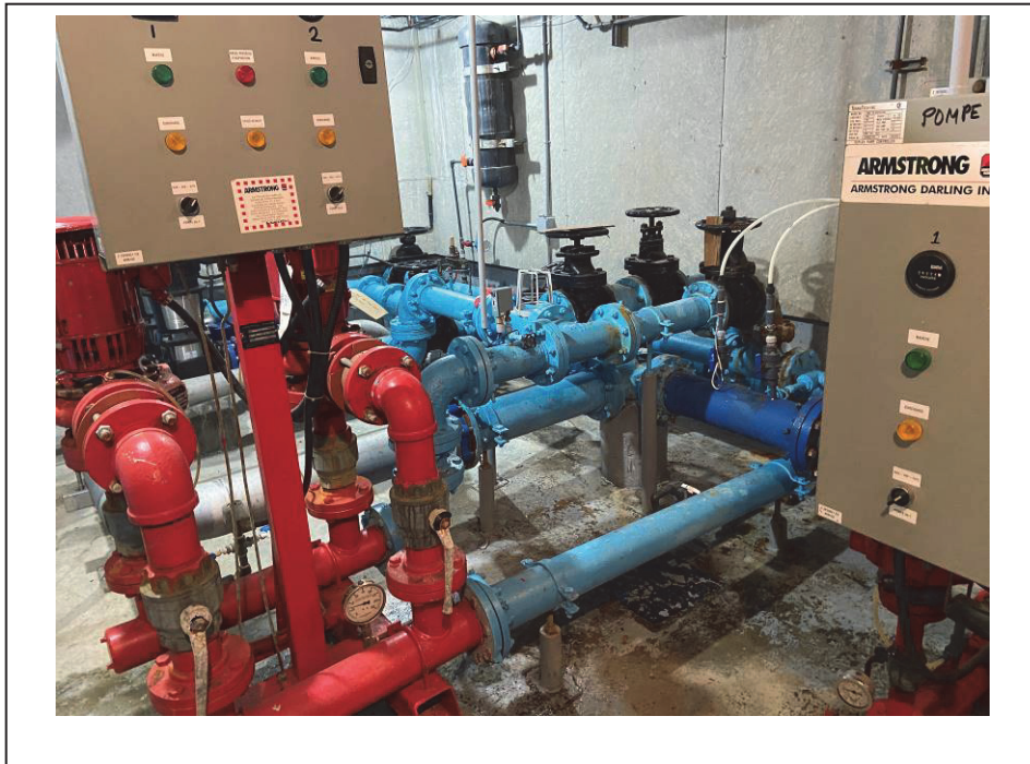
Photo 13 : Canalisation et panneau de contrôle de la station de traitement – 2020-12-18
